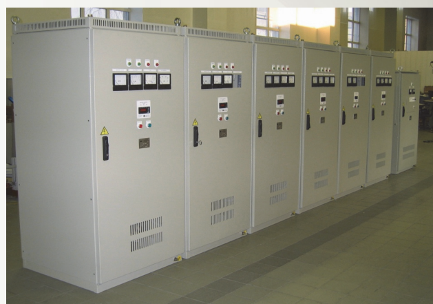
Рис. 3. Пример системы возбуждения со статическими возбудителями
