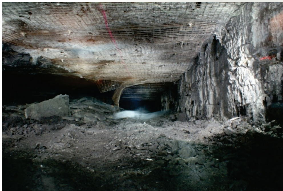
Рис. 11. Состояние камеры «Панели 2-Юг» через шесть месяцев после отработки
